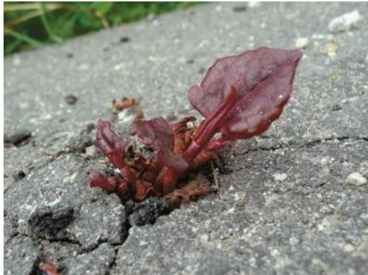
Arten wie Sommerflieder, der Götterbaum oder der Staudenknöterich (Bild) entwickeln eine beeindruckende Sprengkraft. Schäden an Belägen und zusätzliche Unterhaltskosten sind die Folge (Foto Rolf Marschner).
