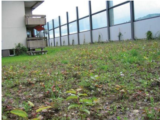
Auf dieser Baustelle wurde rhizomhaltiger Boden eingebaut. Weil der Boden nachher ausgetauscht werden musste, sind Kosten von 13'500 Franken entstanden (Foto planikum GmbH).
